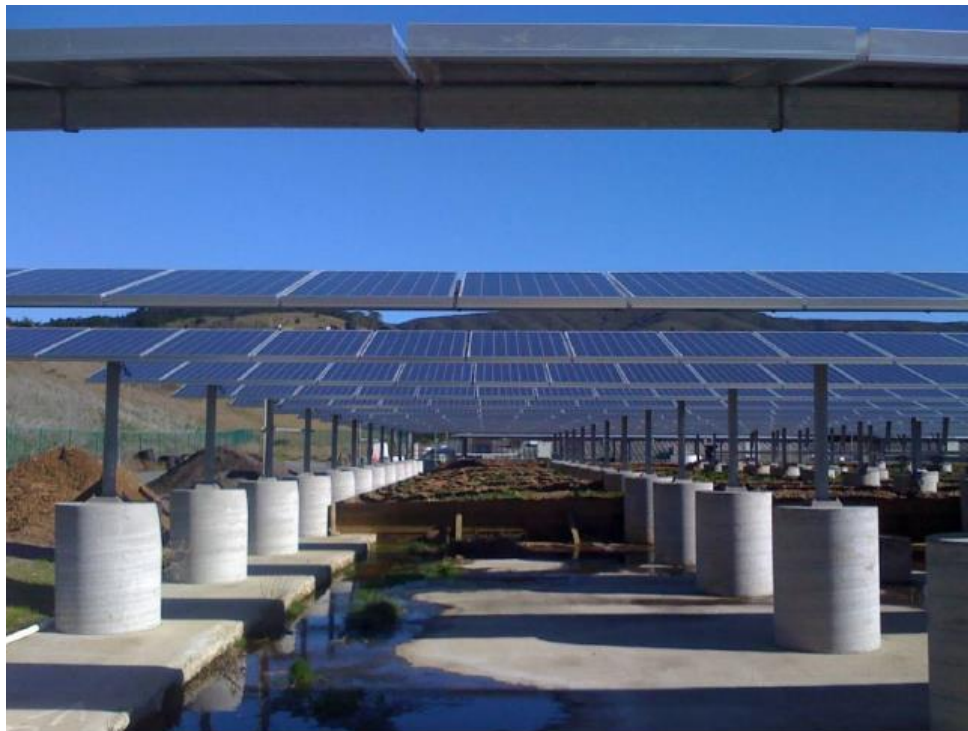
Figura 55. Esempio di impianto fotovoltaico con fondazioni formate da zavorre costituite da plinti in cemento
