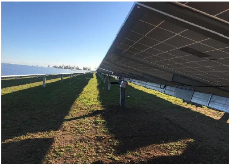
Figura 53. Esempio di impianto fotovoltaico realizzato con supporti costituiti da pali in acciaio infissi direttamente nel terreno
